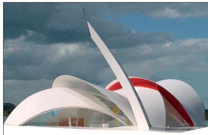
Ontwerpmaquette van Royal Haskoning. Goed zichtbaar zijn de gekleurde Rodeca gevelpanelen die de verbinding tussen de schalen vormen.
