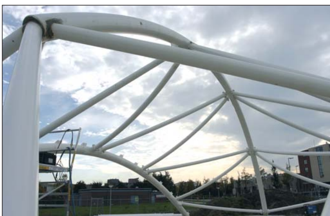
De staalconstructie is door De Klerk Werkendam volledig 3D uitgetekend en tot op de millimeter nauwkeurig geproduceerd en gemonteerd.
