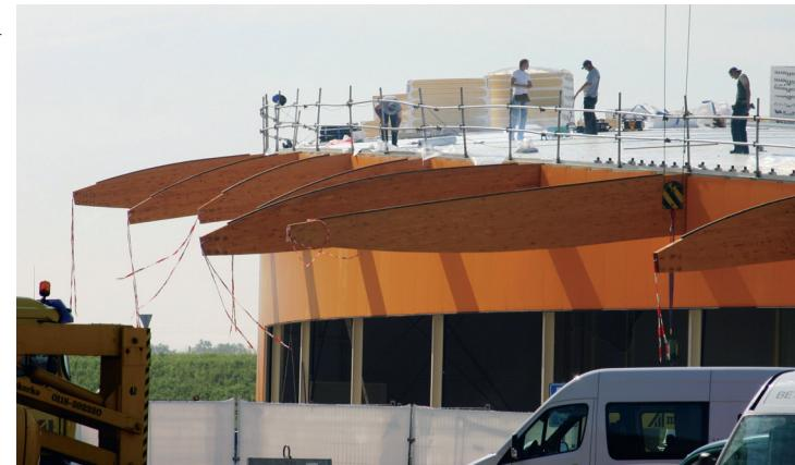
1. Langs de goot is het membraan bevestigd met een kederprofiel aan stelbouts.
