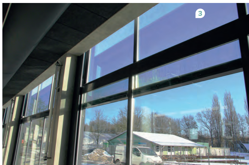
1 // De architectuur van het bad is afgeleid van een Romeins zuilenbad. De galerij kan ook als tribune worden gebruikt. 2 // De gevel is in drie horizontale delen opgedeeld, waarvan het onderste deel te openen is. 3 // De bovendorpel van de hefpui werkt in gesloten toestand samen met de onderdorpel van de bovengelegen pui.
