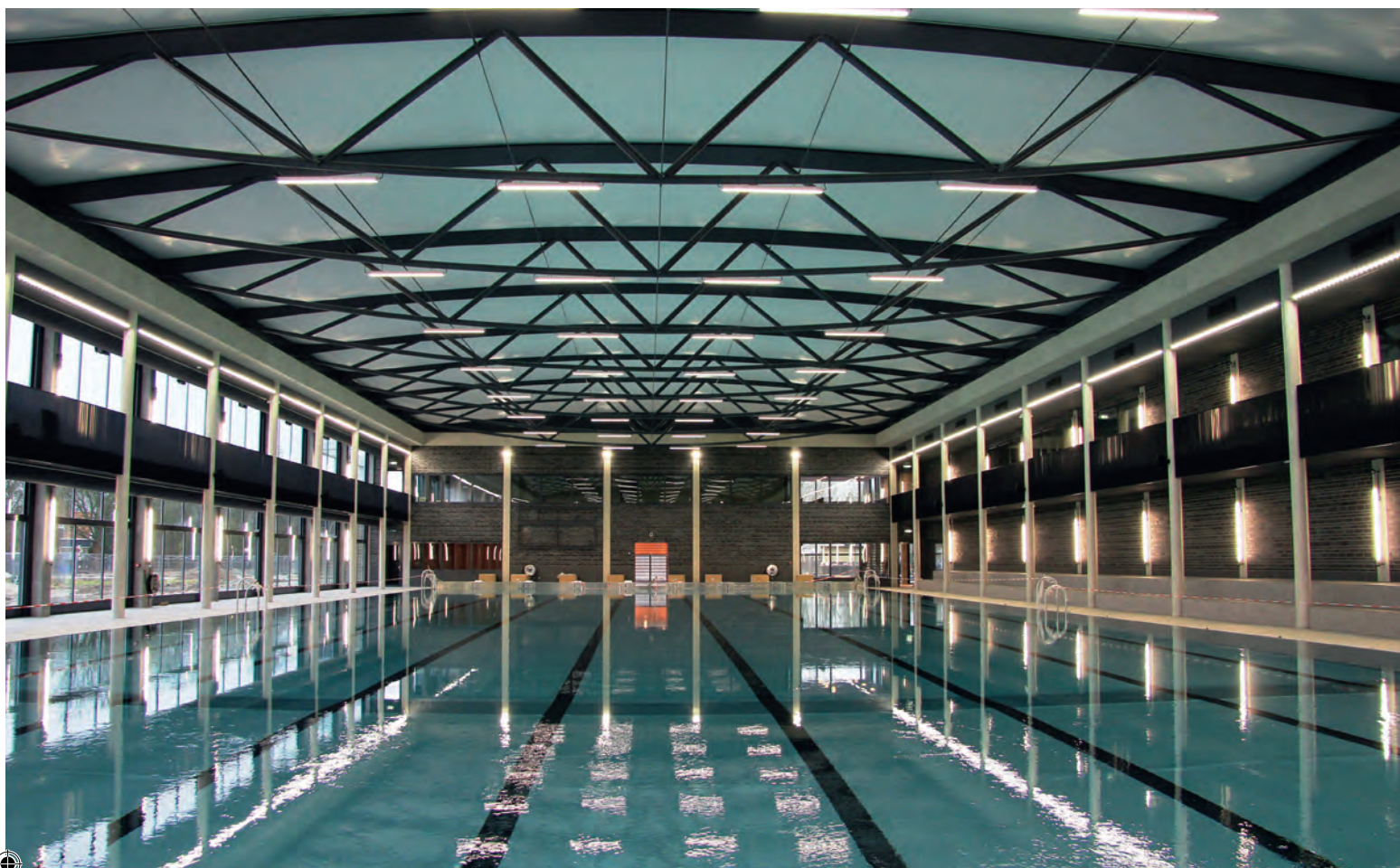
Het luchtkussendak is bewust niet translucent gemaakt. Dit voorkomt verblindende schitteringen in het water.
